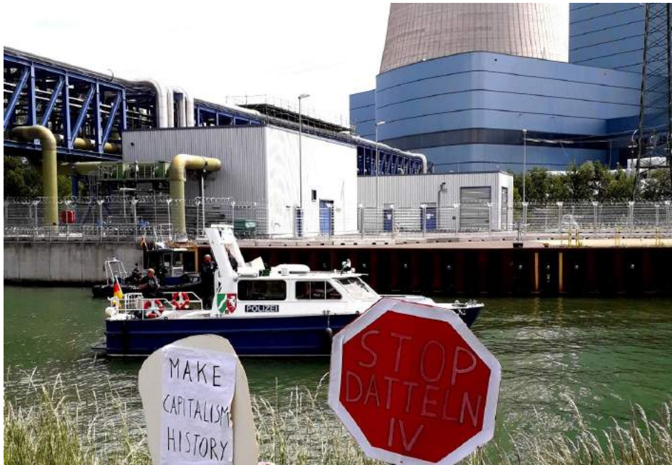
Gegen das Kohlekraftwerk Datteln IV gibt es seit langem Proteste: Es verbrennt blutig abgebaute Steinkohle aus Kolumbien, es stößt trotz gedrosselter Leistung derzeit 4 Millionen Tonnen CO 2 pro Jahr aus und obendrein ist es ohne Genehmigung gebaut worden. Polizei die Landesregierung haben es leider repressiv geschafft, viele Aktivitäten der Klimabewegung in Datteln zurückzudrängen.
